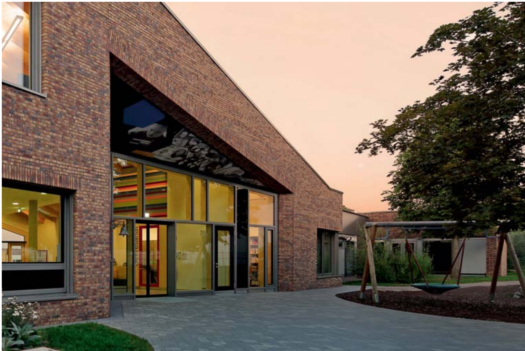
Der Röben Handstrich-Verblender WIESMOOR erd-bunt, DF macht aus energetisch saniertem Altbau (rechts im Hintergrund) und Neubau optisch ein homogenes Ganzes.
