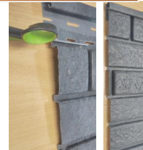
Подготовка панелей к монтажу последнего ряда
