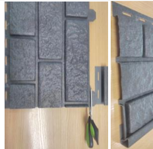
Подготовка панелей к монтажу первого ряда
