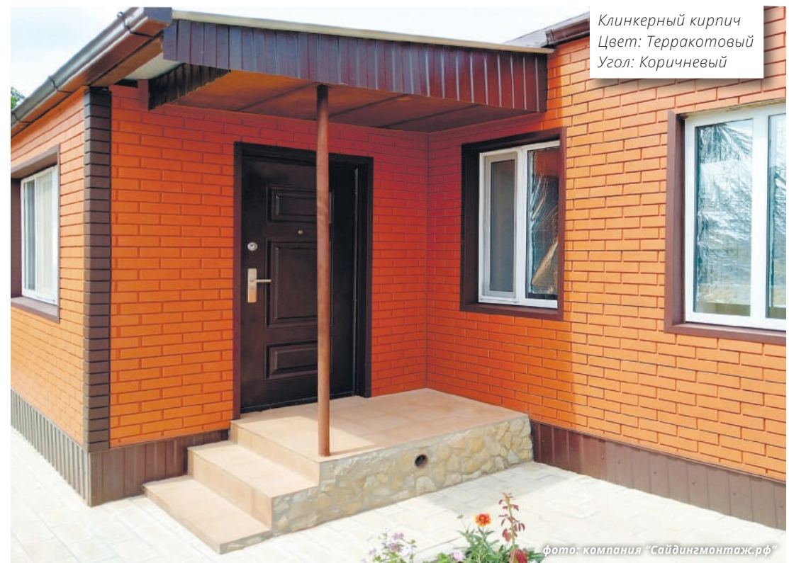
фото: компания "Кровля фасад Челябинск"
