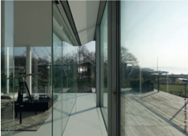
◀ Doppelglasfassade mit zwischen den Scheiben integrierten Jalousien.
