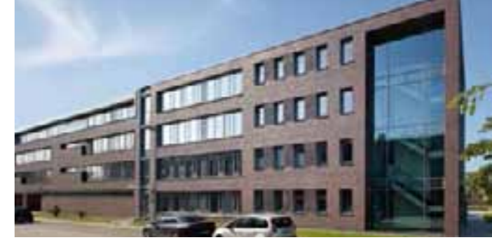
Auf die Vertikale gesetzt - Bürogebäude, Münster, Seite 52
